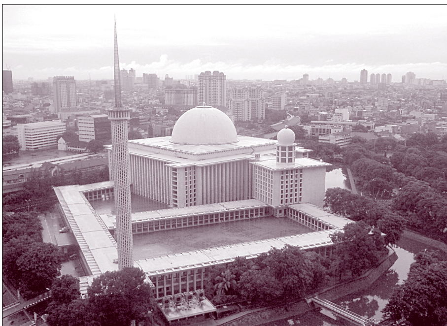
نمای بیرونی مسجد استقلال - جاکارتا
