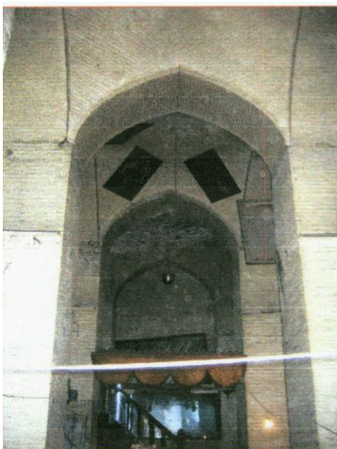
۲. ستون‌ها و فضای داخلی آب‌انبار سید اسماعیل. (گزارش ثبتی: آب‌انبار سید اسماعیل، اردیبهشت ۸۵)
