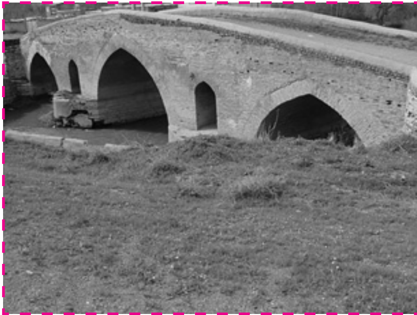
تصویر شماره ۱: نمای طاق‌ها و آبشکن‌های پل فرسفج
