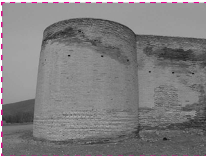
تصویر شماره ۷: نمای برج و باروهای جبهه غربی کاروانسرای فرسفج
