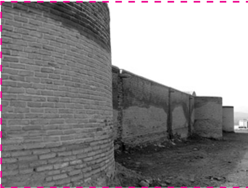
تصویر شماره ۹: نمای برج و باروهای جبهه غربی کاروانسرای فرسفج
