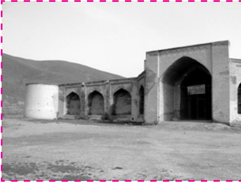
تصویر شماره ۲: نمای مدخل ورودی کاروانسرای فرسفیج
