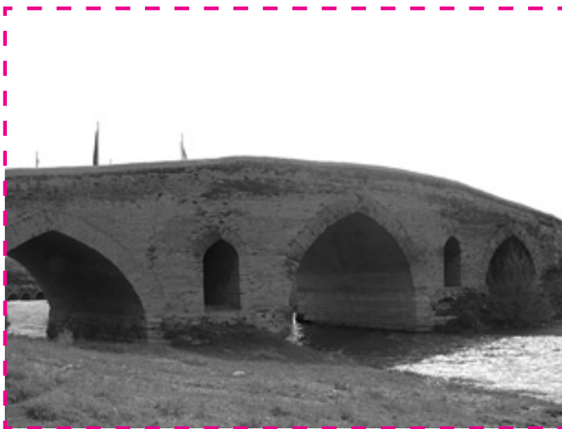
تصویر شماره ۲: نمای پل فرسفج
