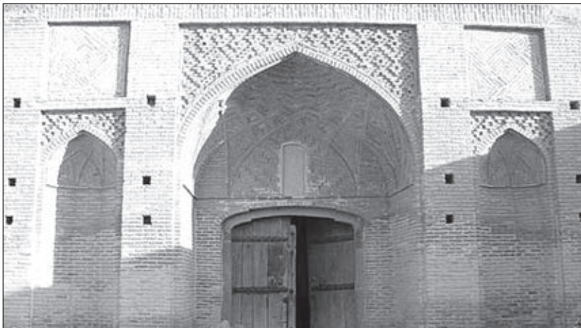
تصویر ۳: درب ورودی کاروانسرای حاج کمال
