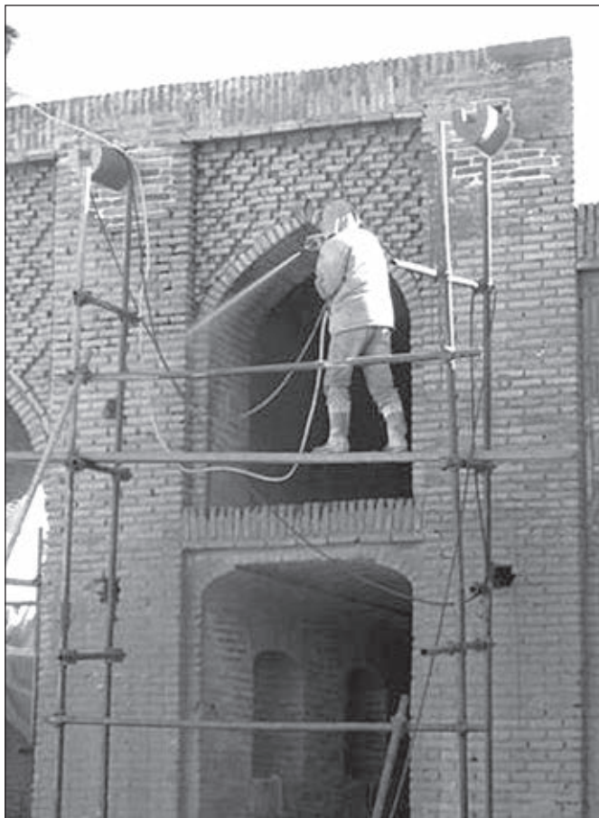
تصویر ۱۱: مرمت ایوان شمال غربی
