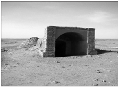
تصویر شماره ۱- نمای ورودی حوض انبار خاکی
