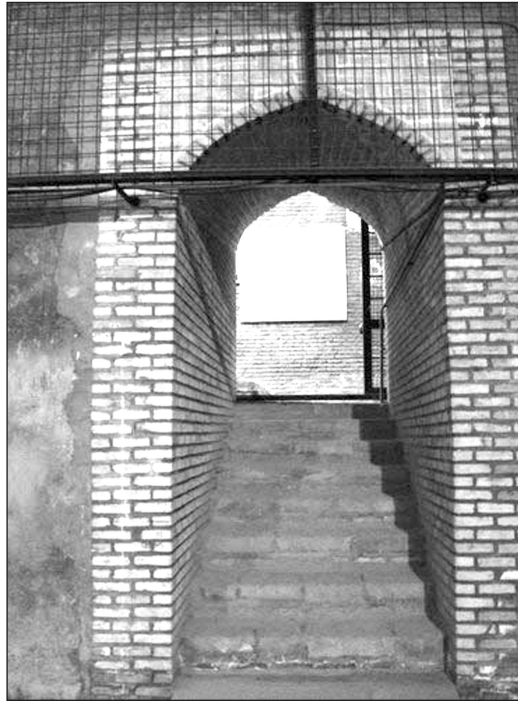
پله‌های ورودی به مخزن اصلی آب انبار
